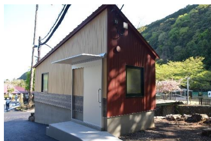
●作業倉庫（備品貸出場所）
